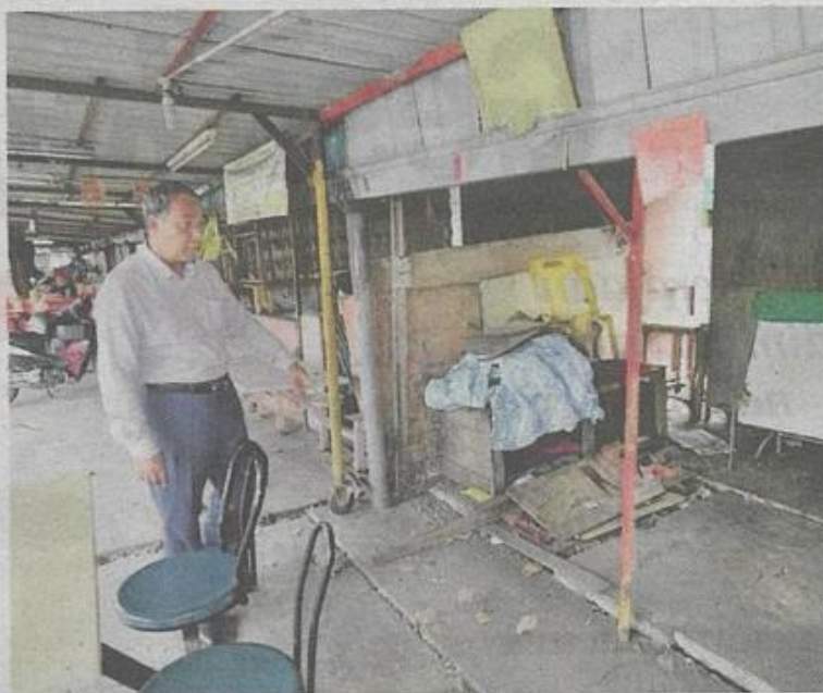
Mohamad Yasid melihat keadaan Gerai Makan MPK di Simpang Empat Teluk Pulai yang bakal dirobohkan bagi projek pelebaran jalan.
